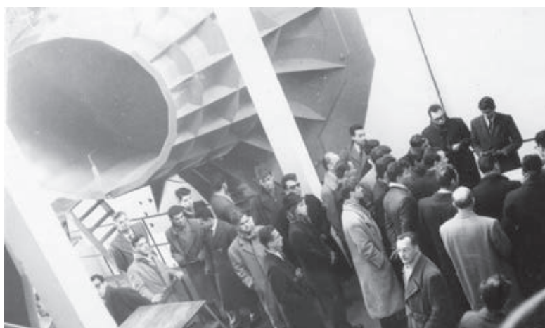
Visita a Túnel de Vento em Lisboa, T61
